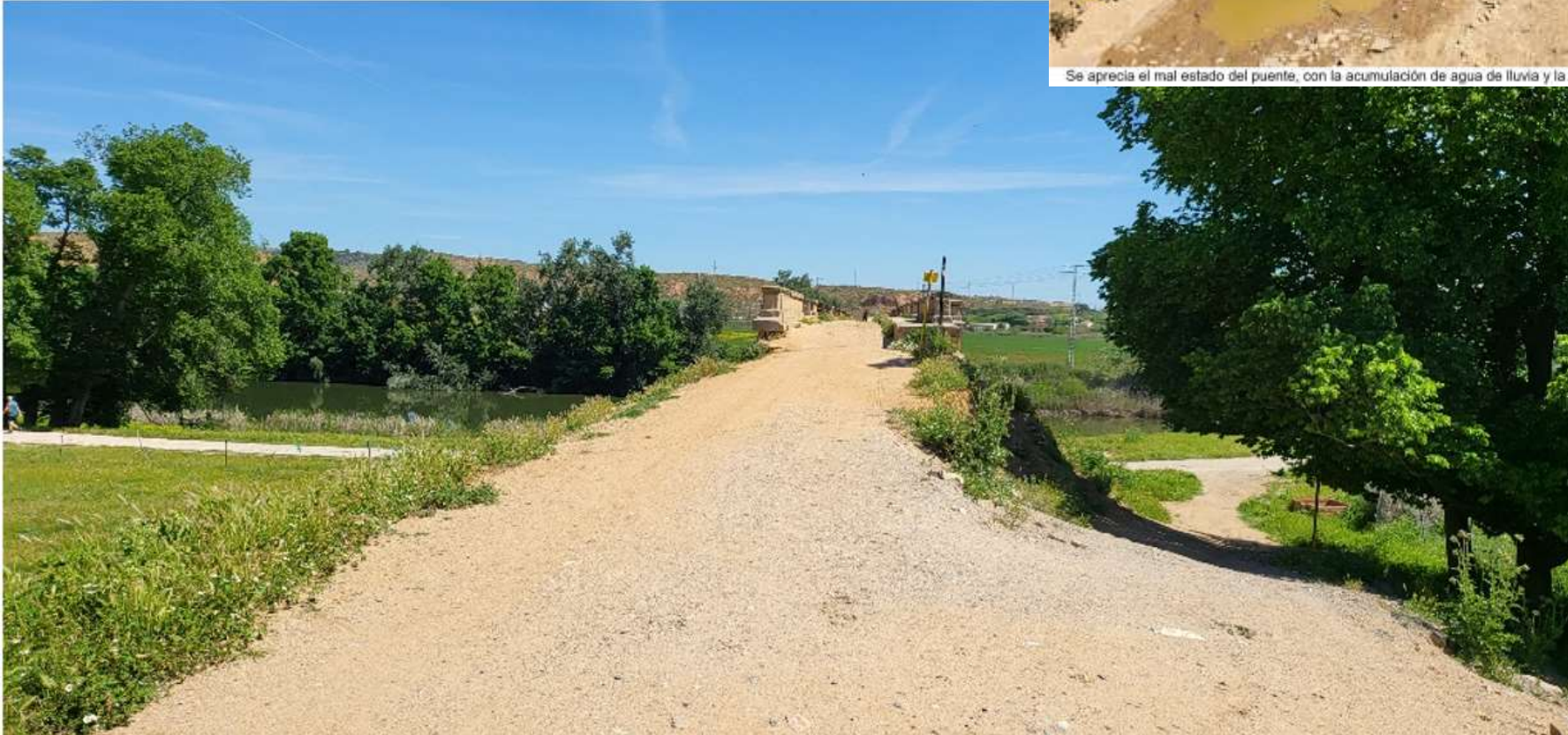
El camino sube de cota para entrar en el puente sobre el río. Se puede observar cómo se conecta con la senda ecológica, que pasa por debajo y continúa hasta el barrio de Santa María de Benquerencia
