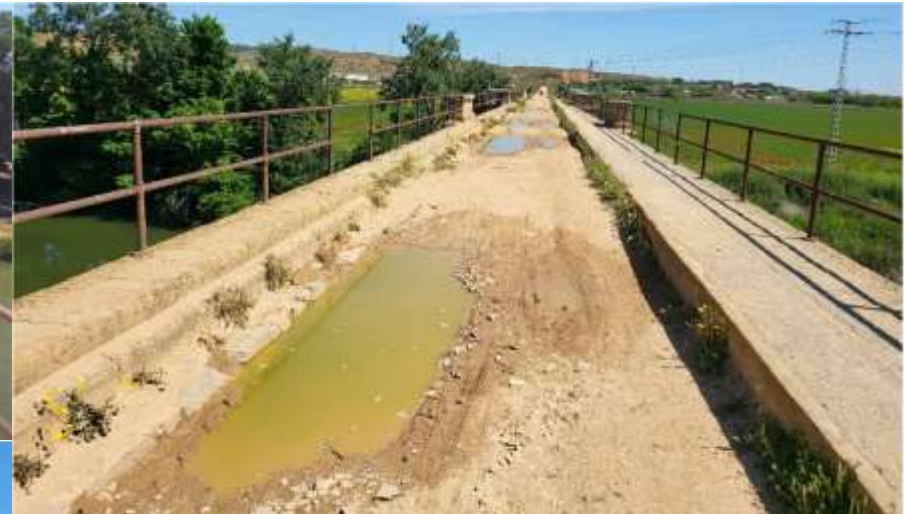
Se aprecia el mal estado del puente, con la acumulación de agua de lluvia y la falta de algún elemento de las barandillas
