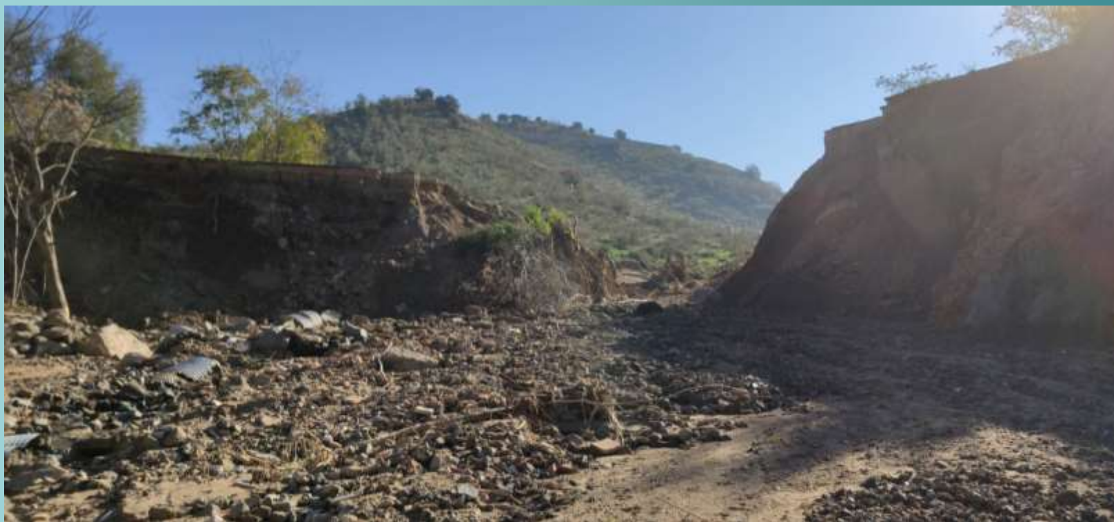
Restos del talud del vial provisional tras avenida de septiembre de 2021
